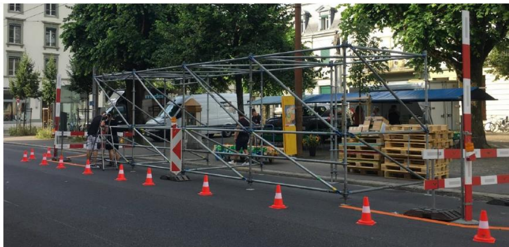
Figure 2 : Structure en échafaudage composée de quatre modules de 2,5 mètres de côté
