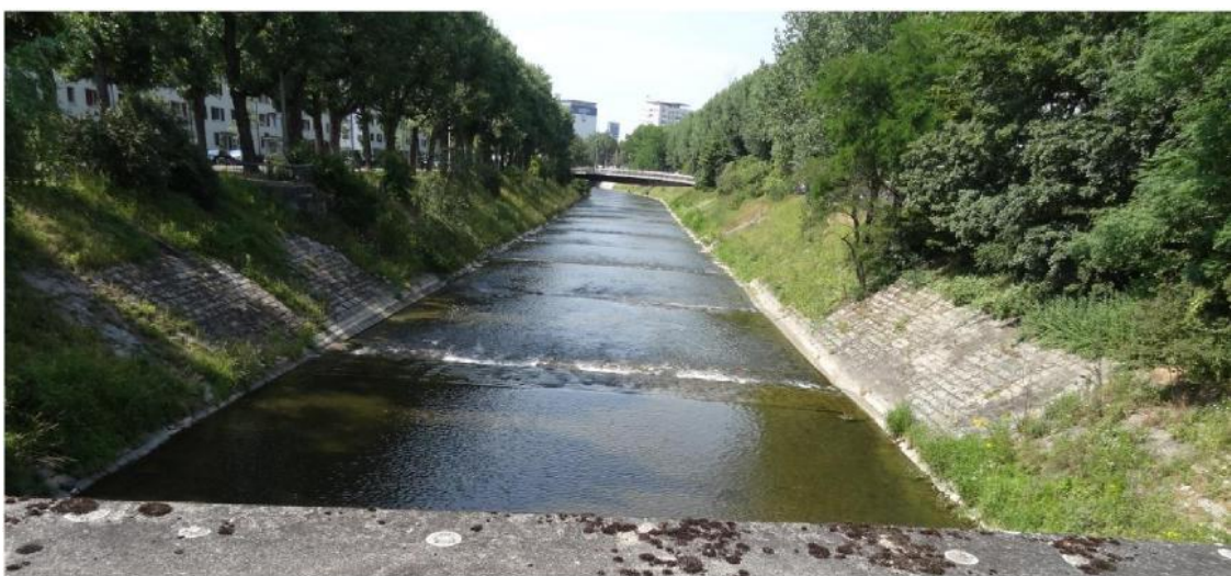
Abb.1: Die Wiese im Unterlauf vor der Revitalisierungsmassnahme: Monotones Trapezprofil mit Schwellen
